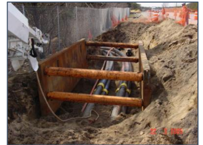
Conduit Installation
