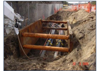
Instalación de conductos
