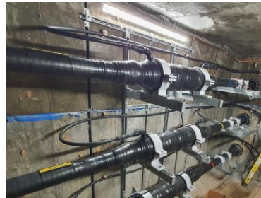
Empalme de cables
