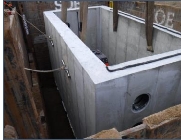
Instalación de bóveda
