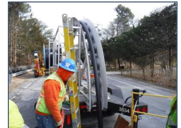
Instalación de cables
