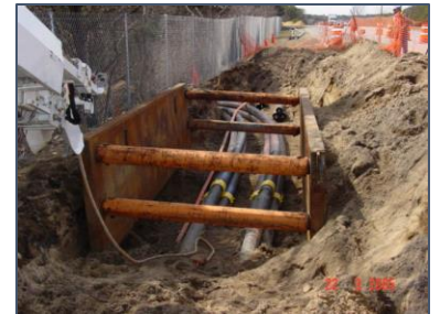
Conduit Installation
